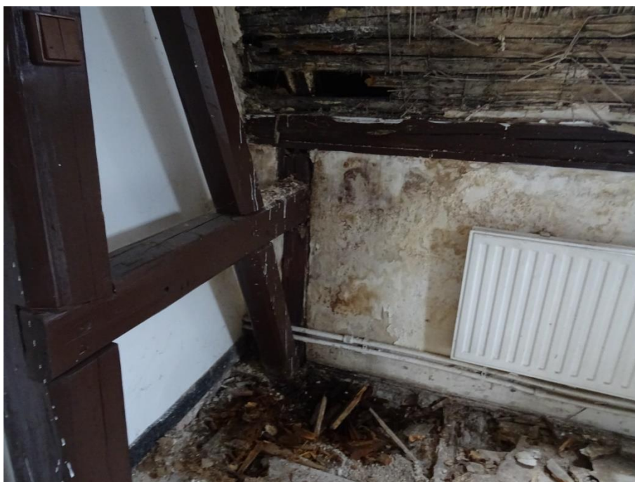
Místa odběru vzorků č. 1, 2 Nahoře outkovka , dole dřevomorka
