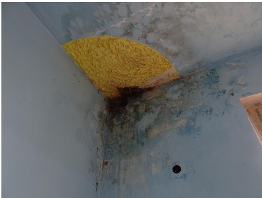
Vzorek č. 8 - stará plodnice dřevomorky na stropě 2. NP, která souvisí s nálezy ve vz. č. 2 a 3
