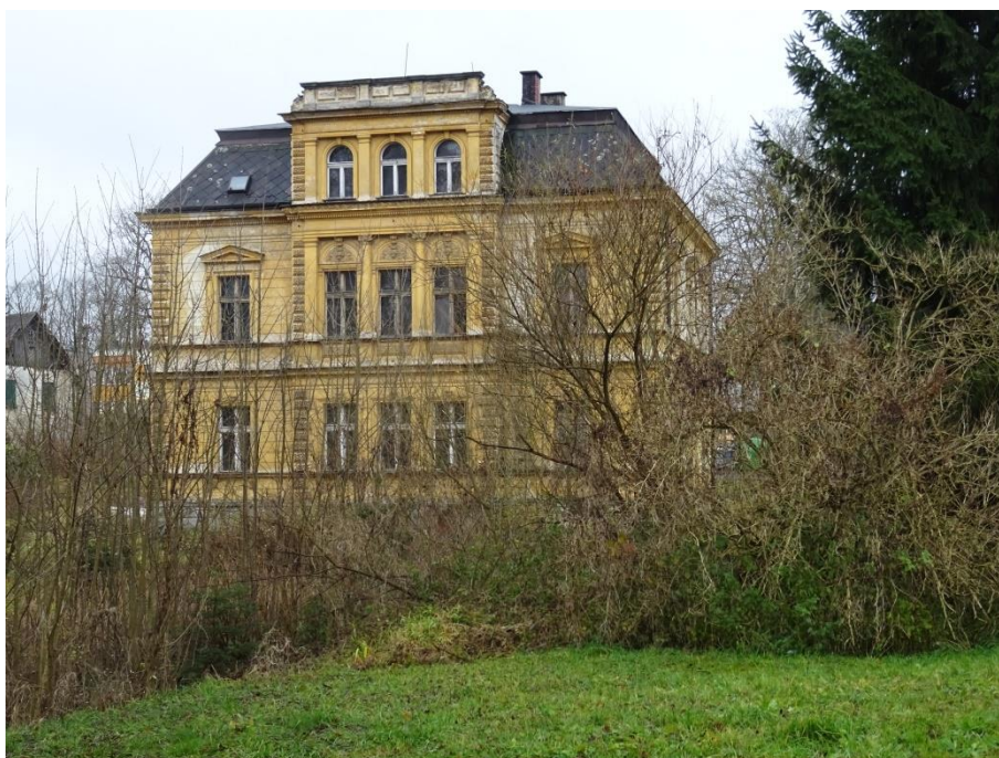
Celkový pohled z východní strany, vlevo od podkrovních oken je poškozené úžlabí, které bylo příčinou vzniku ohniska dřevomorky v podlaze
