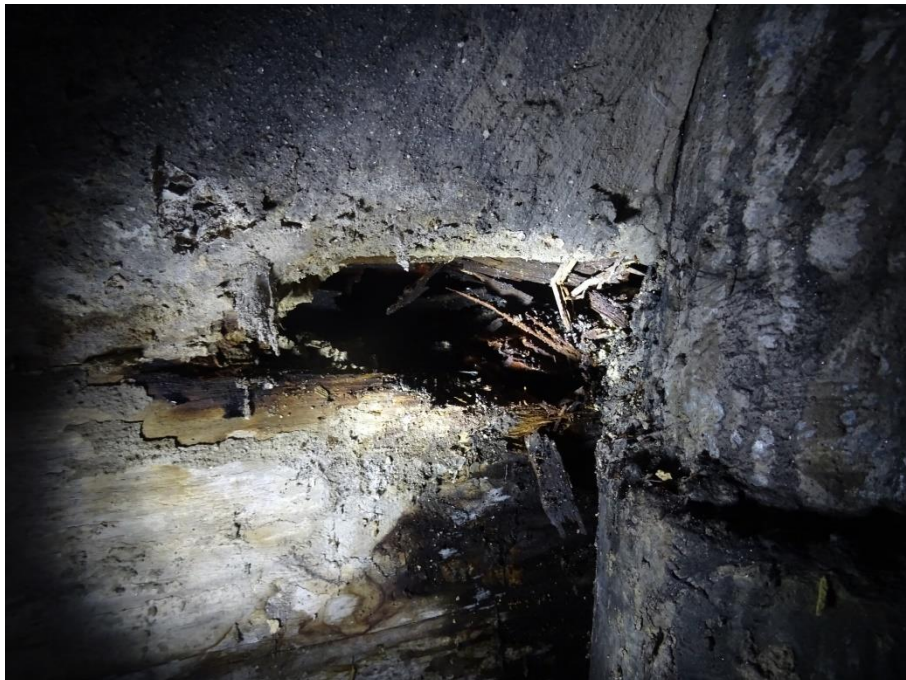
vzorek č. 6, pozednice, trámovka a outkovka
