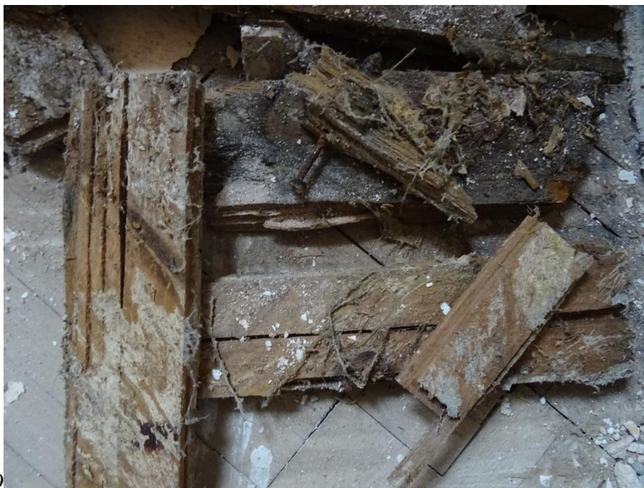
Detail vzorku č. 3 - dřevomorka
